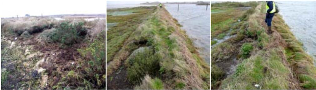
Erosion des levées d'argile.
