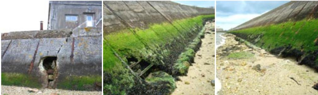
Affouillement d'ouvrage en béton.
