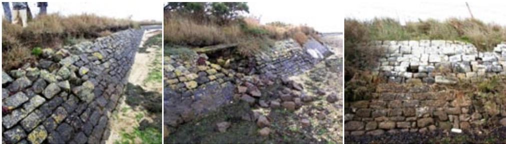
Dégradation d'ouvrages en pierre appareillée.
